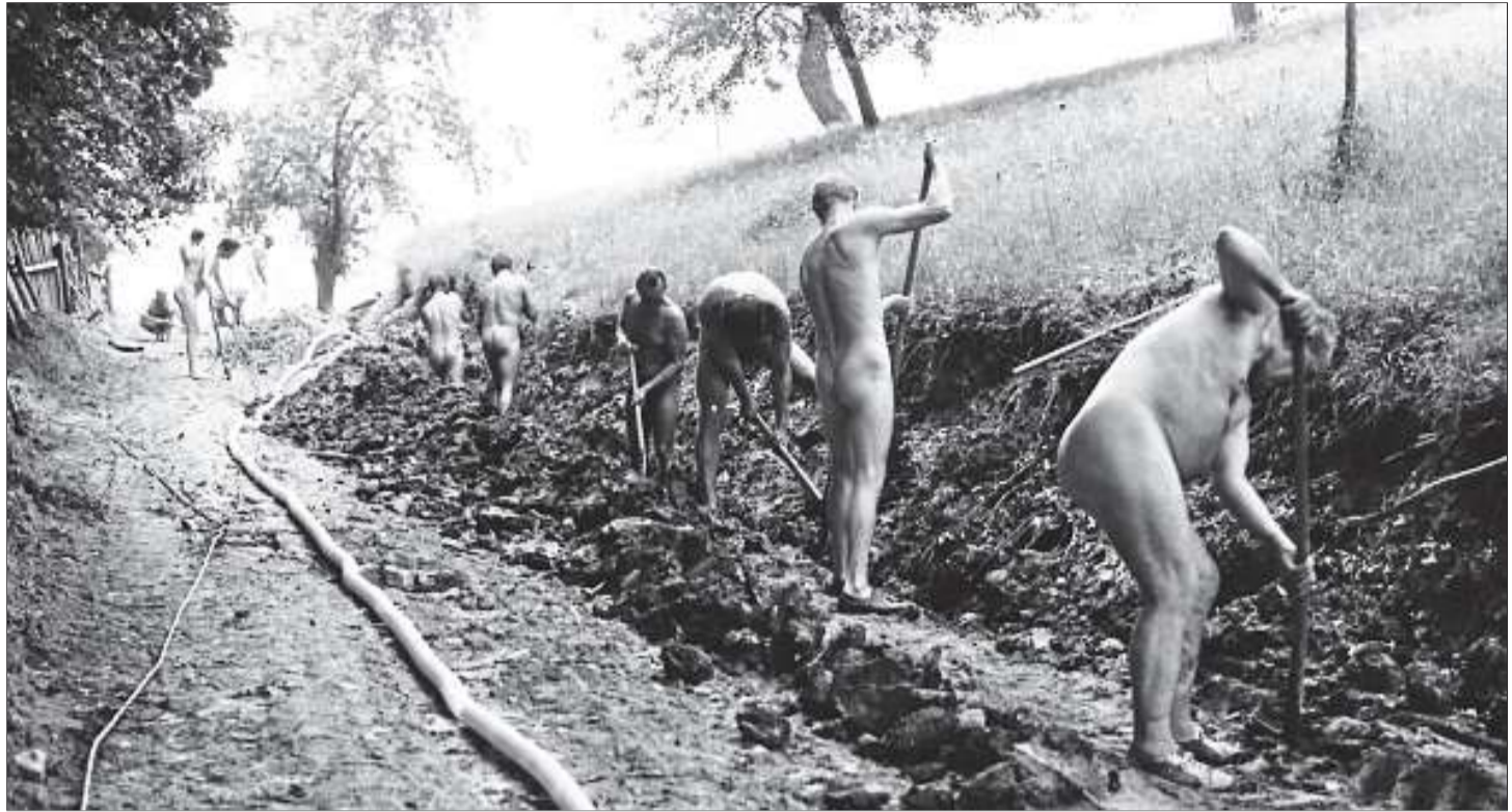
Mitglieder bei der Arbeit: Sie haben die Anlage in Eigenregie aufgebaut – hier wurde um 1977 ein Weg verbreitert und so eine Zufahrt geschaffen.
